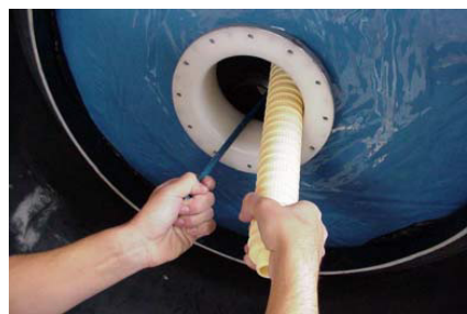
3: Placez l'assemblage à l'intérieur de la bouteille pour monter les crépines latérales.
