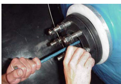
5: Vissez l'adaptateur de bride sur l'assemblage. Assurez-vous que le joint torique est correctement positionné dans l'adaptateur.
